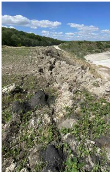
Рис. 4.14. Рови відсідання Рис. 4.15. Зсув, утворений насипних грунтах біля брівки насипу
