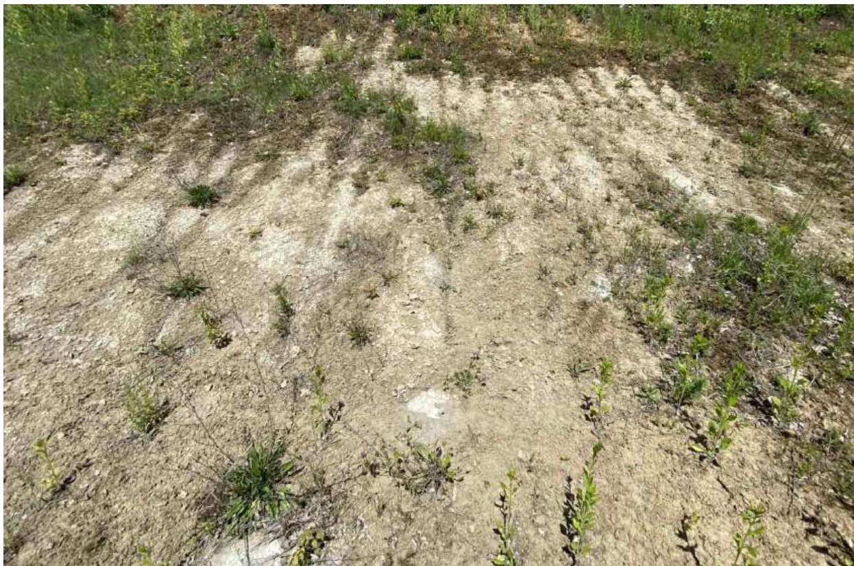
Рис. 4.13 Дрібноструменевий розмив на уступі у південно-східній частині кар'єру
