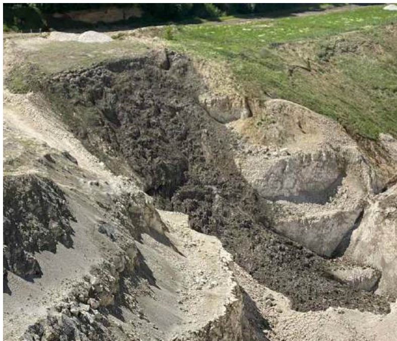
Рис. 4.14. Рови відсідання Рис. 4.15. Зсув, утворений насипних грунтах біля брівки насипу
