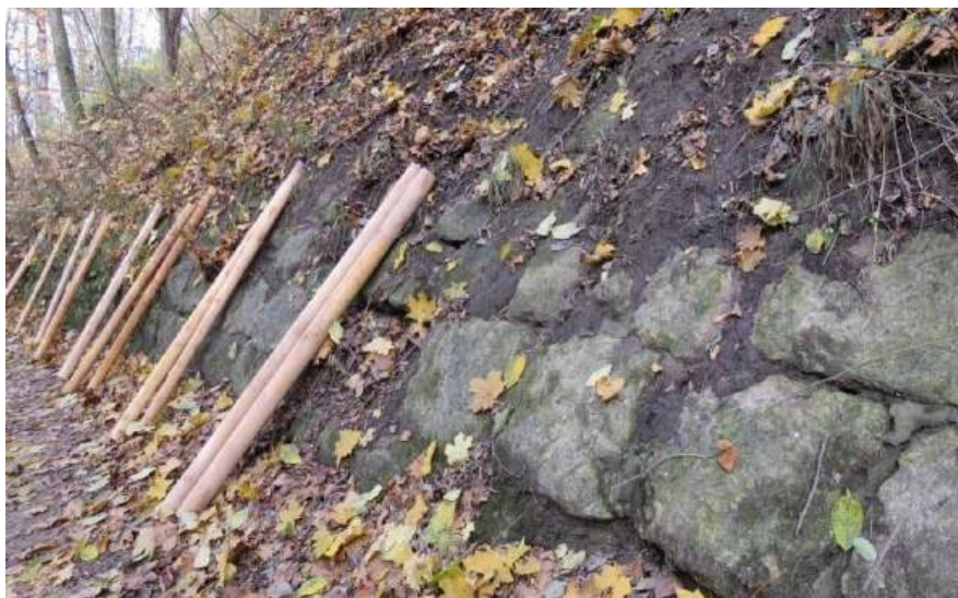
Рис. 2.9 Штучне укріплення стінки схилу (XIX ст)
