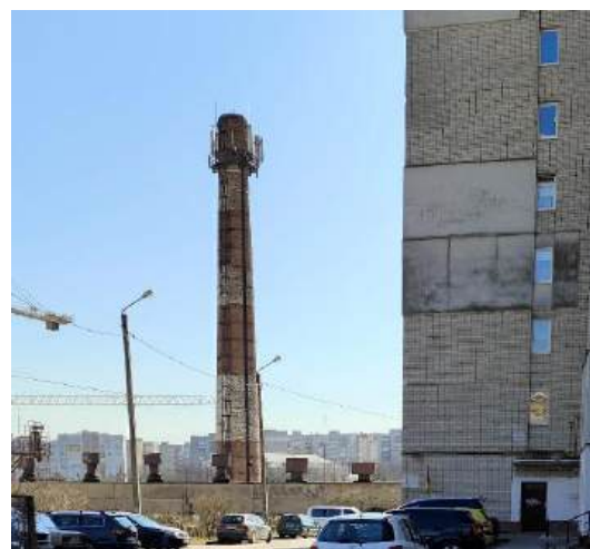
Рис. 29. Котельні Личаківського району теплових мереж, вул. Китайська, 12а
