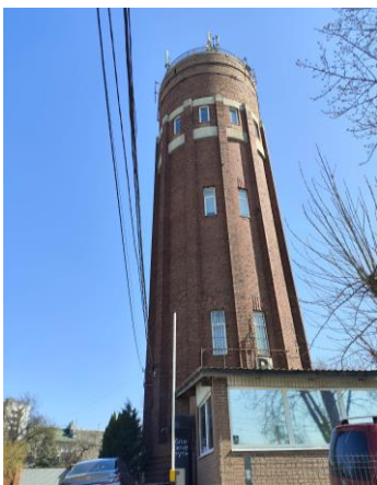
Рис. 14. Водонапірна вежа, вул. Пасічна, 67 (світлина Л. Котик, березень 2025 р.)
