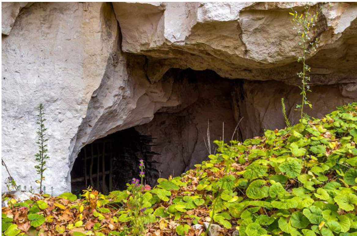
Рис. 15. Іванковецькі штольні, зовнішня вентиляція
