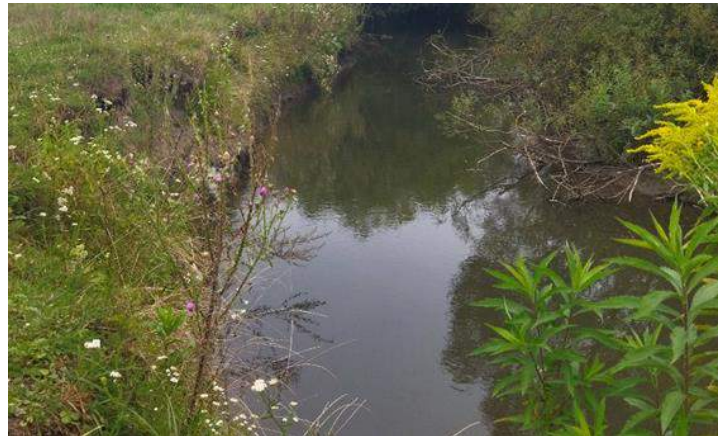
Рис. 5.7. Береговий уступ з мікрозсувами, в декількох місцях видно тріщини по яких блоки дернини зсуваються вниз по схилу (с. Кологори)
