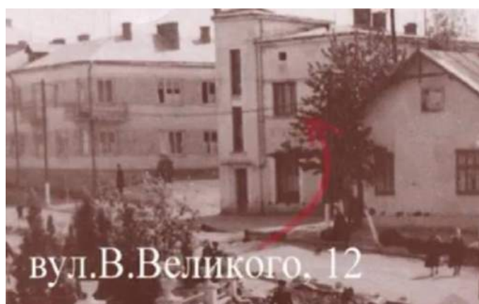
Рис. 7. Будинок на вул. В. Великого, 12 до вибуху газу 1972 р.
