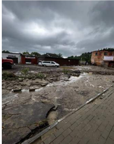
Рис. 3. Пошкодження асфальтового покриття на вул. Зарічна внаслідок паводка 10.06.2023 (фото автора)
