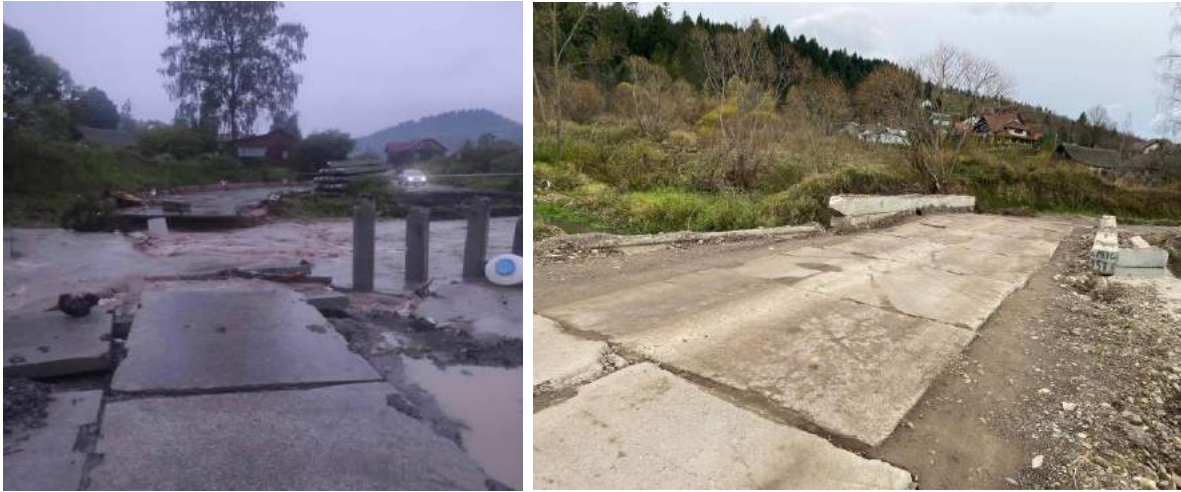
Рис. 5. Міст між смт. Східниця та с. Новий Кропивник (ліворуч – фото зруйнованого моста 10.06.2023, праворуч – відновлений міст) (фото автора)
