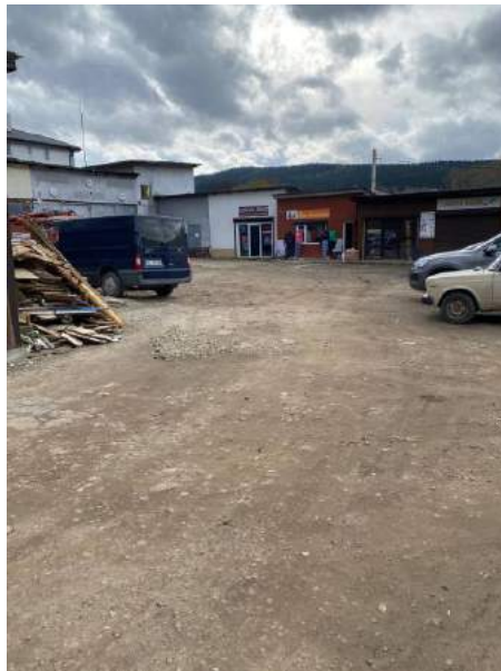
Рис. 4. Стан дорожнього покриття станом на 05.11.2023 (фото автора)
