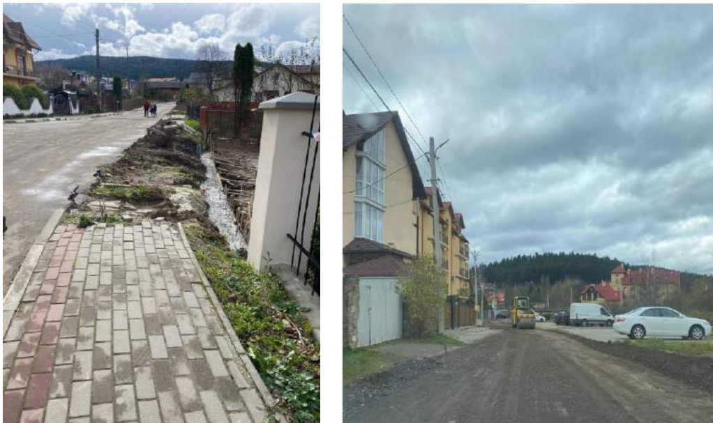
Рис. 6. Усунення наслідків паводку (ліворуч – ремонт узбіччя по вул. Зарічна, праворуч – ремонт частини дороги по вул. Зарічна) (фото автора)
