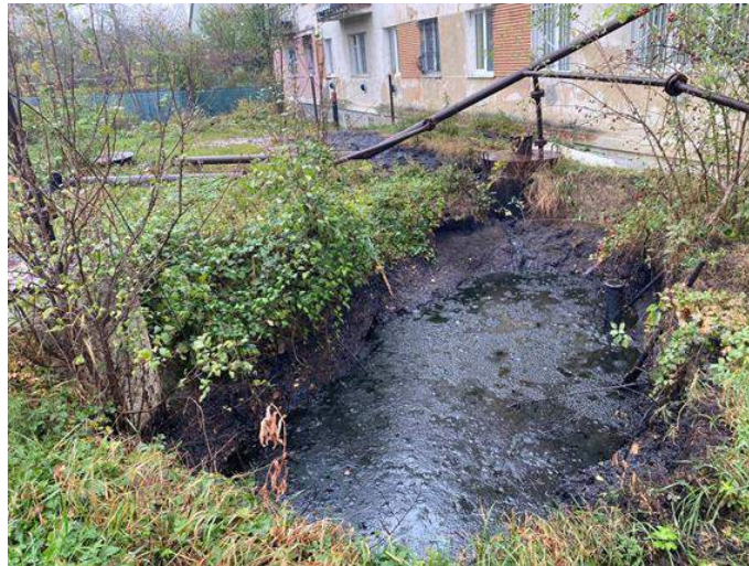
Рис. 10. Вихід нафти під вікнами житлового будинку на вул. В. Чорновола, 12 (фото автора)
