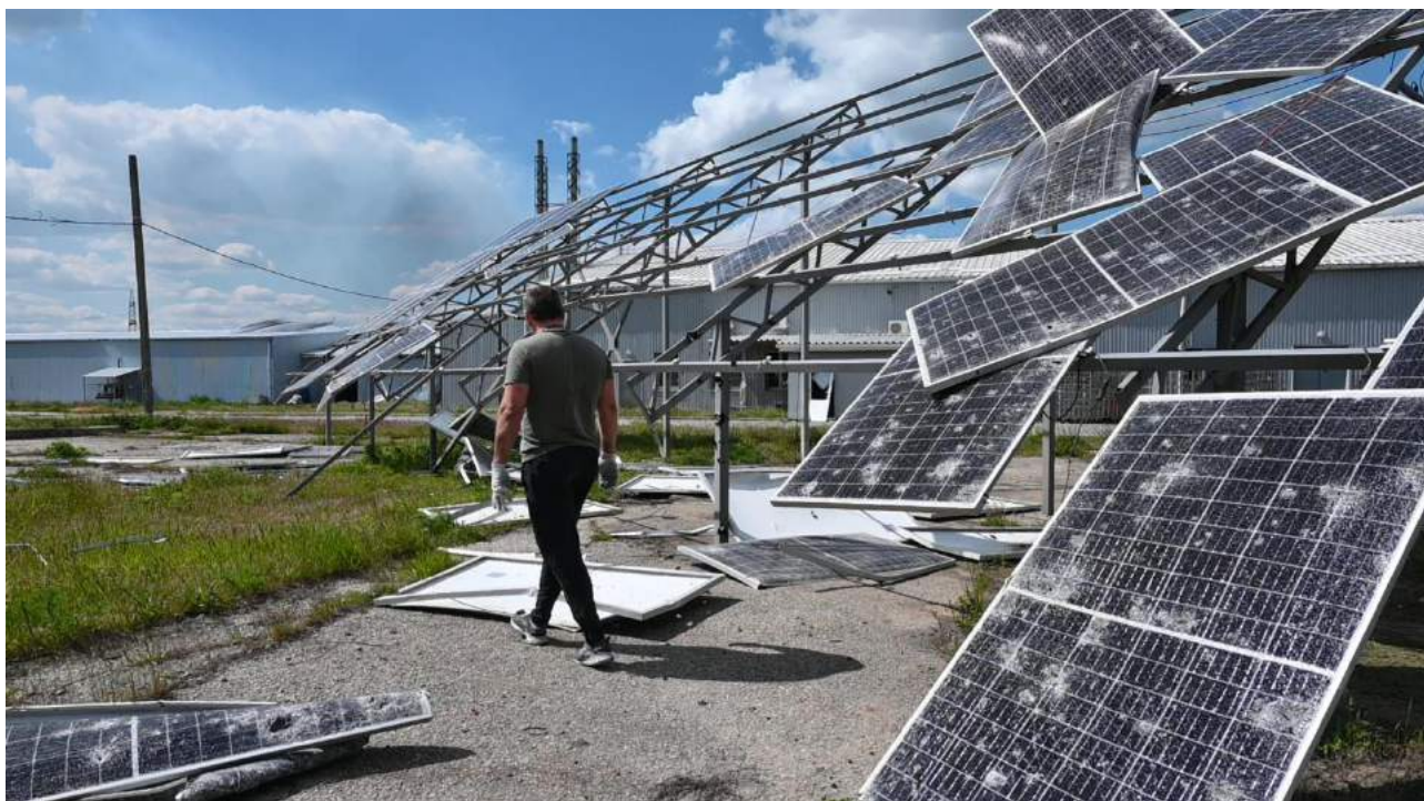
Рис. 18 Зруйновані сонячні електростанції в наслідок російсько-української війни
