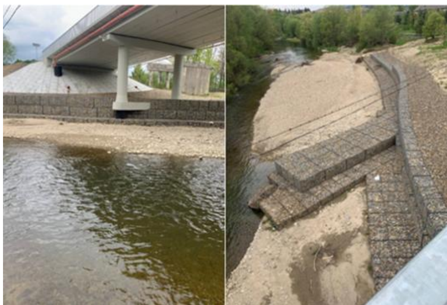
Рис. 5.1. Встановлення захисних конструкцій на березі р. Стривігор у м. Хирів [24].
