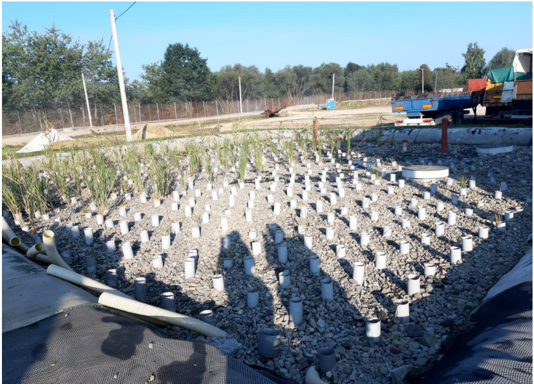
Рис 6. «Біоплата герметичне» на досліджуваному свинокомплексі. Джерело: власні фотоматеріали.
