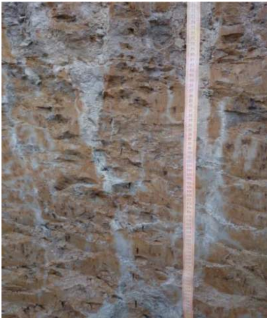
Рис. 3. 4. Вертикальні сілани тріщин.
