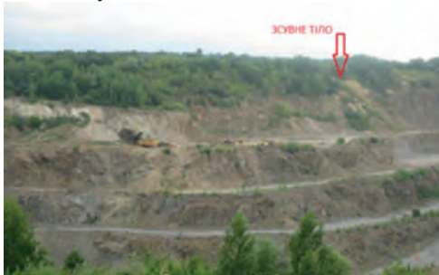
Рис. 10. Розробка та зсувне тіло у верхніх горизонтах західної стінки кар'єру Fig. 10. A place of mining and a landslide body in the upper horizons of the western wall of the quarry
