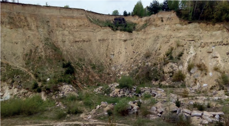
Рис. 7. Уступ розкривної товщі і давній робочий уступ Винничківського кар'єру Fig. 7. Overburden bench and inoperative mine wall of Vynnychky quarry
