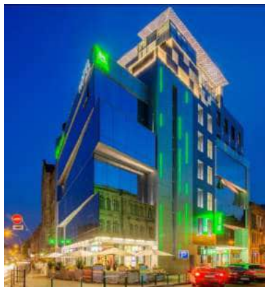
Рис 2.1. Фасад готелю “Ібіс Стайлз” у м. Львів
