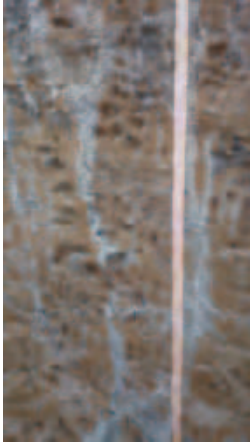
Рис. 2. Вертикальні сілани тріщин.
