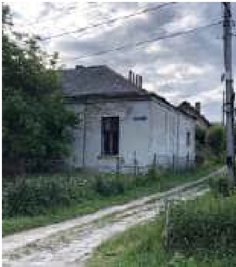
Рис. 2. Занедбана будівля сільської ради та клубу (фото Гудзеляк І., 2021)
