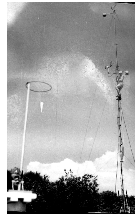
Монтаж дистанційної метеостанції М-47 на висоті 10 м градiєнтної щогли загальною висотою 15 м, 1976 р.
