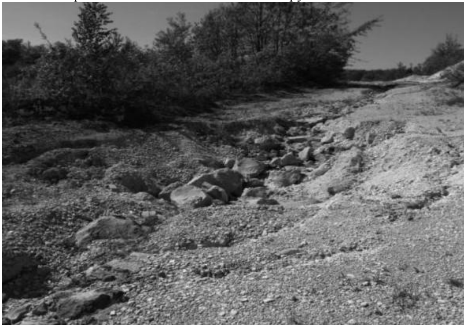
Рис. 4. Лінійна ерозія і просідання вздовж дороги у західній частині кар'єру.
